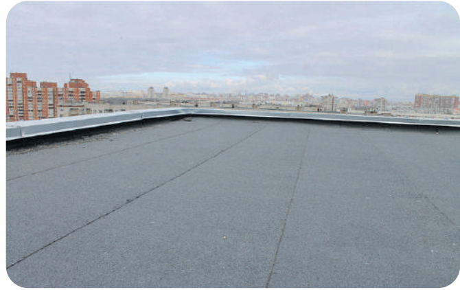
Отремонтированная кровля ул. Генерала Симоняка, д. 3
