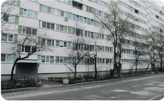
После ремонта фасада ул. Генерала Симоняка, д. 27/193
